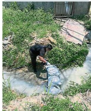
雪州水务管理机构职员将活性炭粉倒入水沟, 避免河流受污染。(照片取自雪州水务管理机构脸书)
