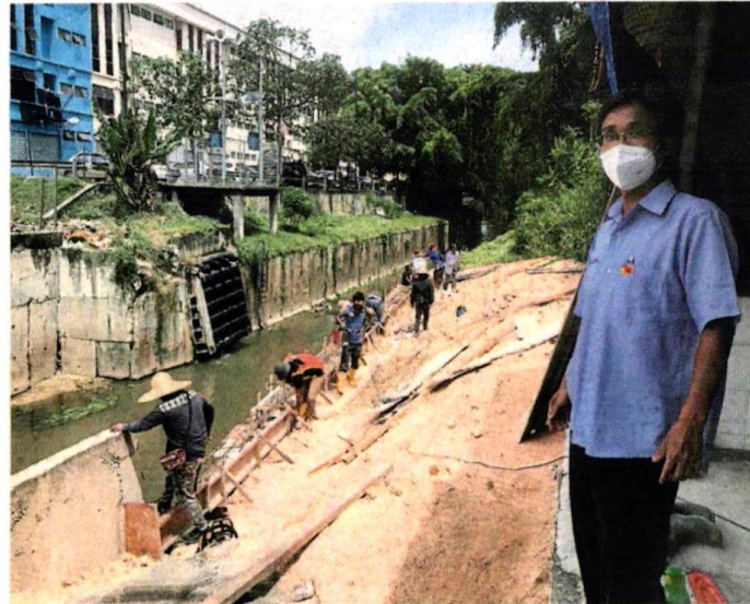
■王声宾巡视直落河河堤维修工程。
