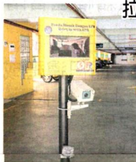
■泊车场入口的扫描摄像头已提升, 更容易辨识到用户车牌。
